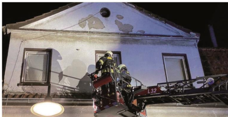
Bröckelnde Fassade in luftigen Höhen: Die Feuerwehr kontrollierte per Drehleiterkorb den oberen Teil des Hauses an der Bahnhofstraße.
