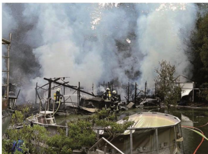
In Herten-Süd haben am Sonntag (20.8.) mehrere Gartenlauben gebrannt. Die Feuerwehr musste mit einem Großaufgebot zum Löschen anrücken.
