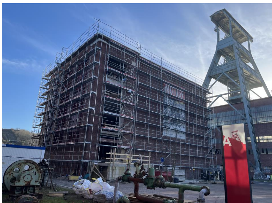
Maschinenhaus Nord ehem. Zeche Ewald
