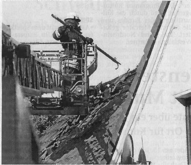
Auf der Suche nach Glutnestern im Dachstuhl entfernt ein Feuerwehrmann von der Drehleiter aus Dachpfannen.
